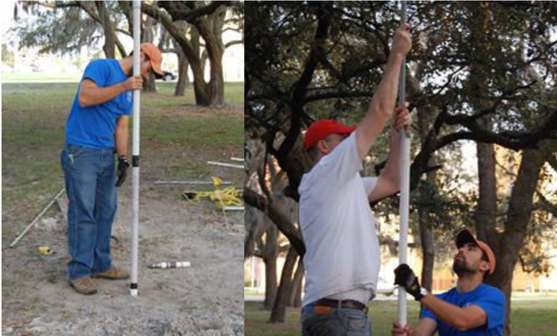
Photo 3 (gauche): en train de mettre le point de tuyau dans le trou (qui est déjà creusé jusque au niveau de la nappe). Photo 4 (droite): après le tuyau est installé jusque à la nappe – on met le petit tuyau galva (15/22mm) dans le tuyaux PVC.
