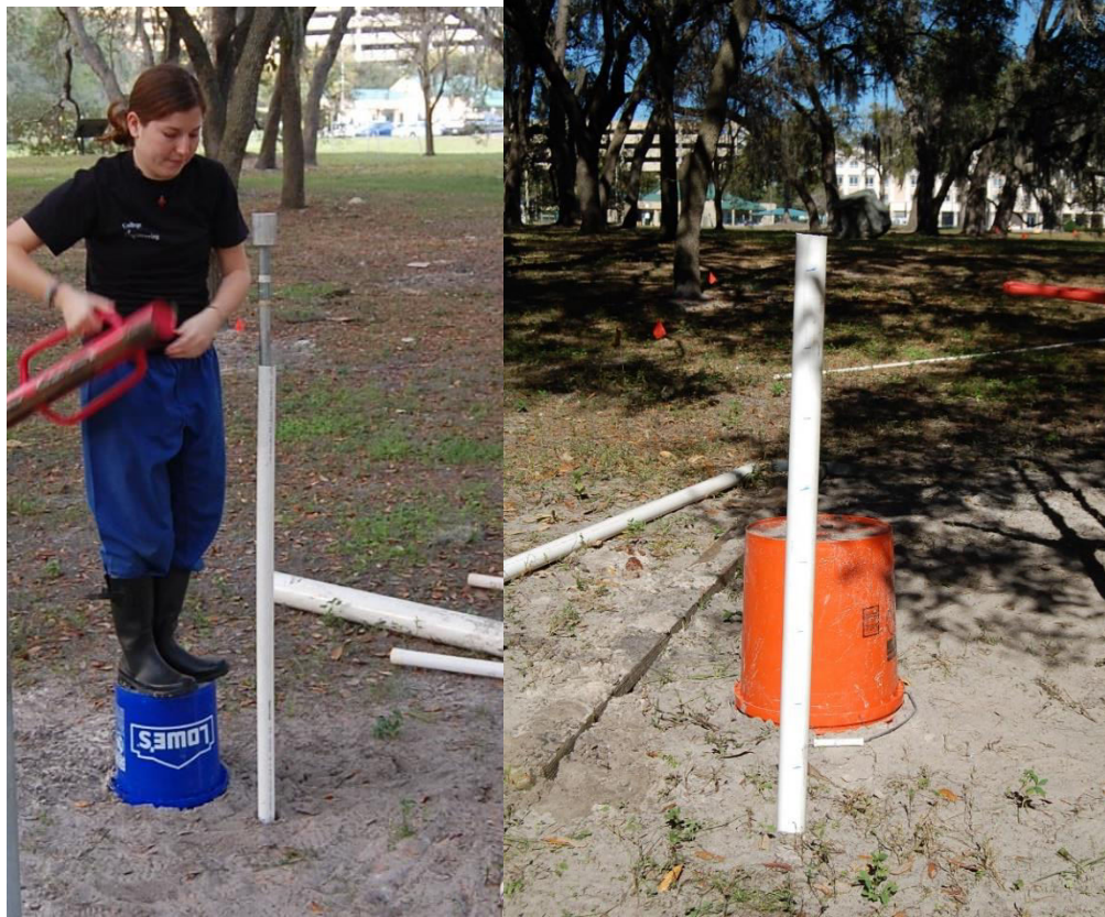
Photo 9 (gauche): Presqu' a la fin de l'installation du forage!
