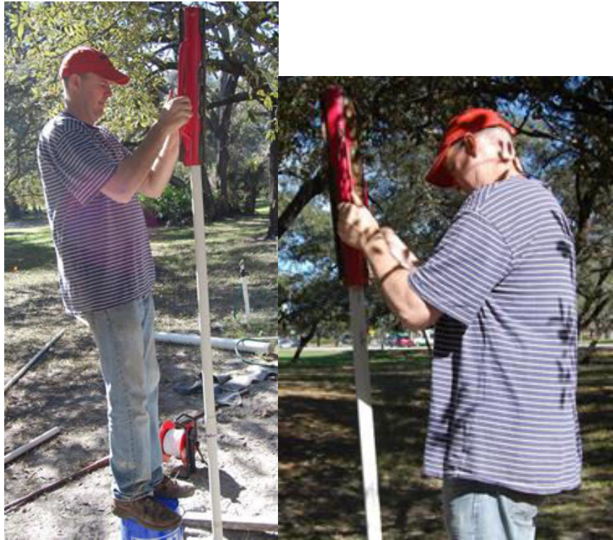
Photos 7 et 8: Tappe le marteau sur le tuyaux galva 15/22mm, qui est installé jusq'ue au niveau de point galva, a l'interieur de tuyaux PVC
